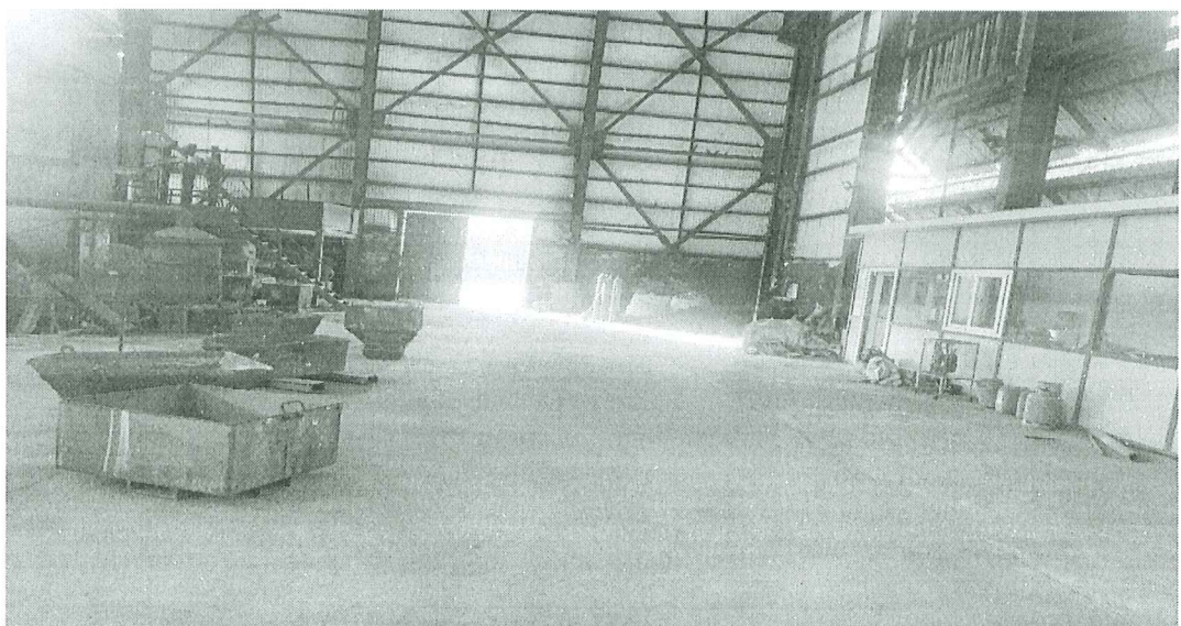
Hình 1.3. Hiện trạng xưởng Luyện thiếc
