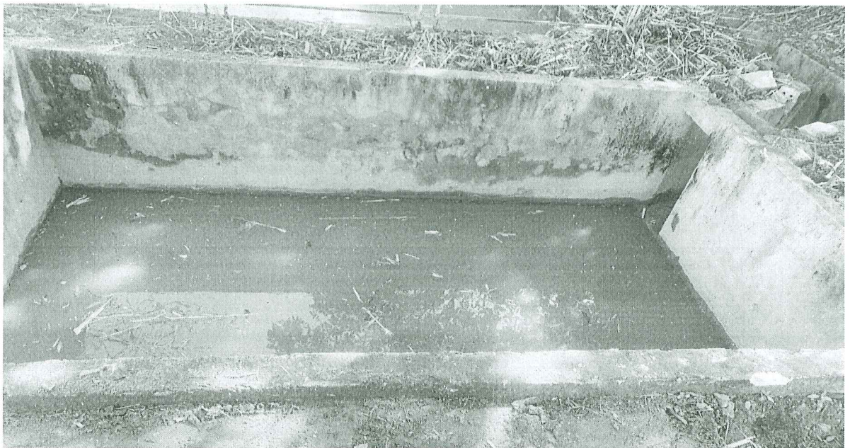
Hình 3.3. Hồ lắng thu gom nước trước khi chảy ra môi trường
