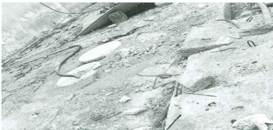
Hình 3.4. Hố Gas thu gom nước thải sinh hoạt
